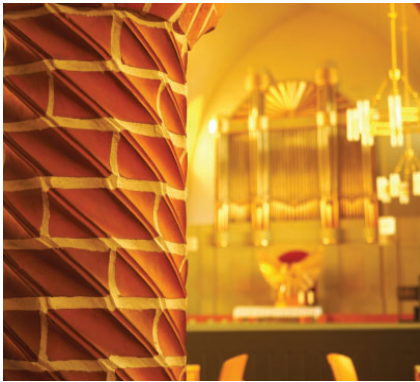
Nach 30 Jahren müssen an der Woehlor-gel Schäden behoben werden.
